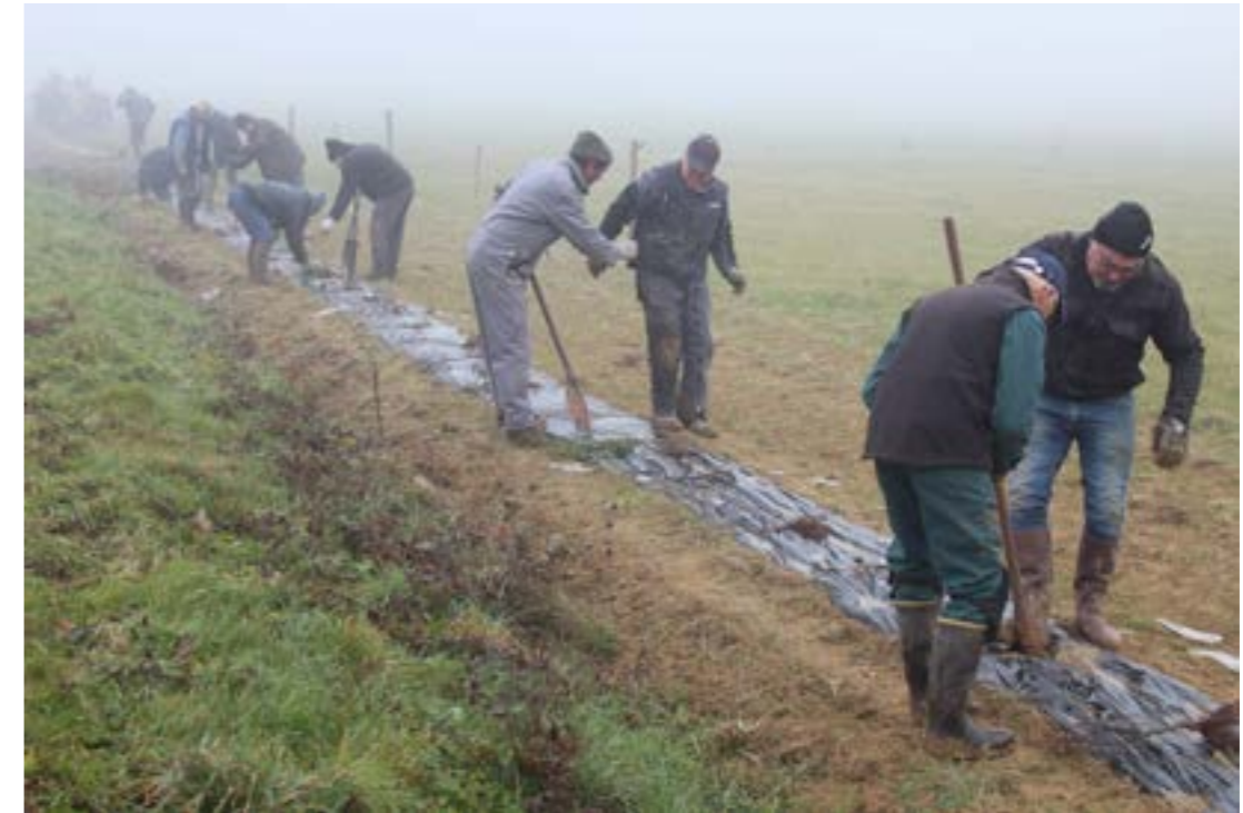
Plantation des haies bocagères
